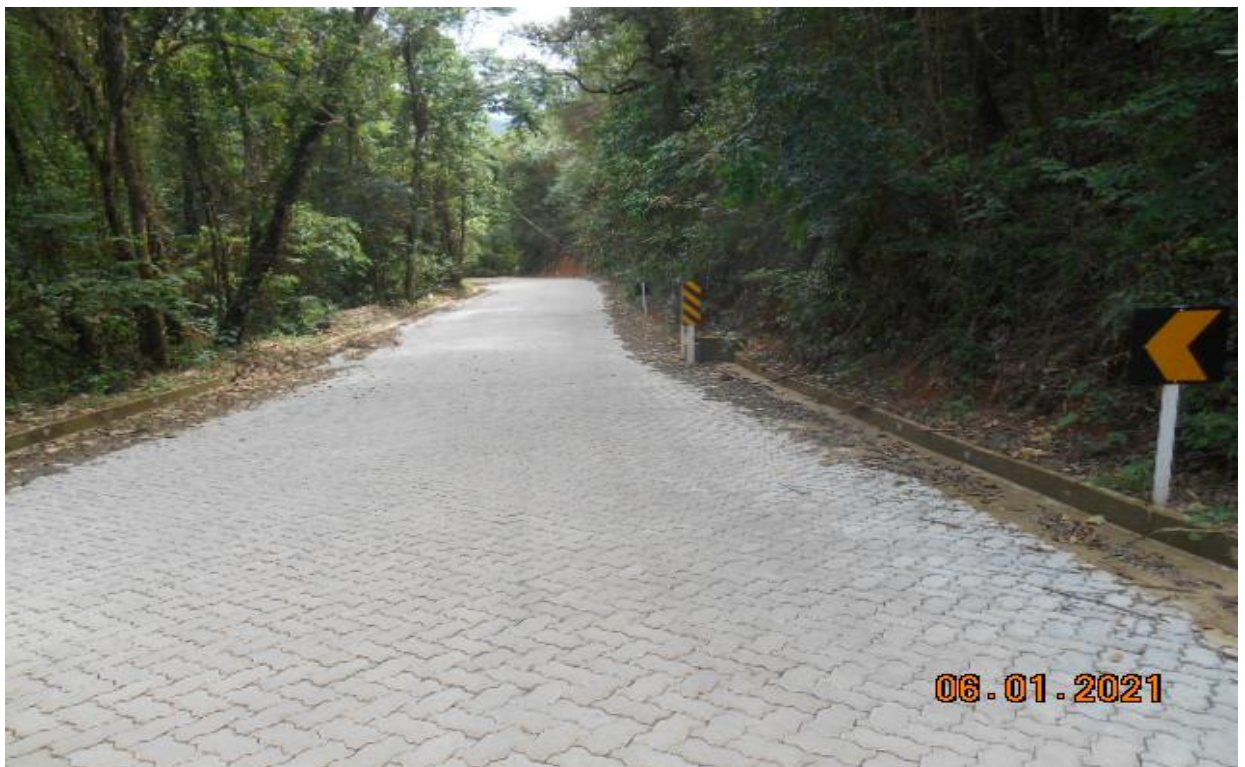
Foto 4 – Vista frontal da rua do Taquaral
