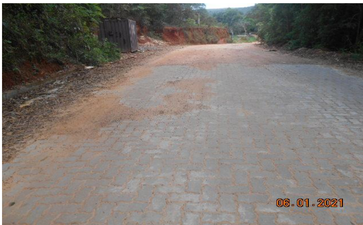
Foto 6 – Vista frontal da rua do Taquaral
