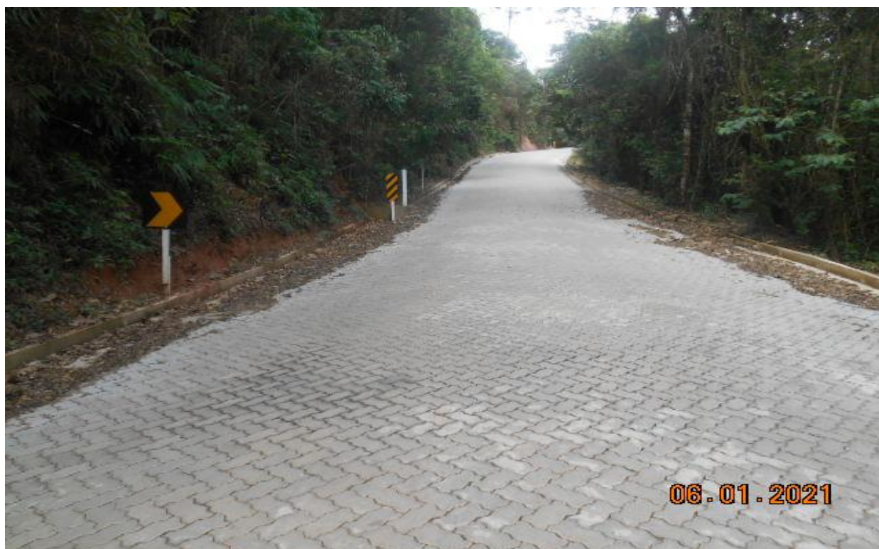
Foto 5 – Vista frontal da rua do Taquaral
