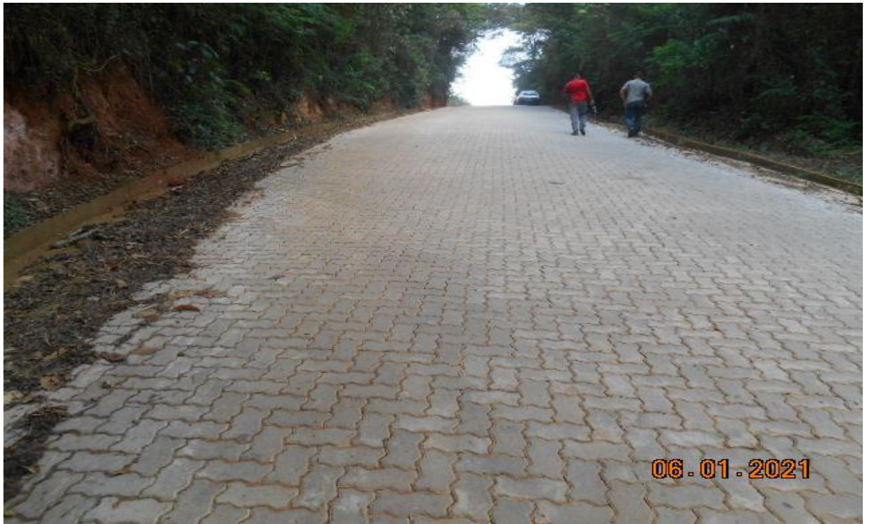
Foto 7– Vista frontal da rua do Taquaral
