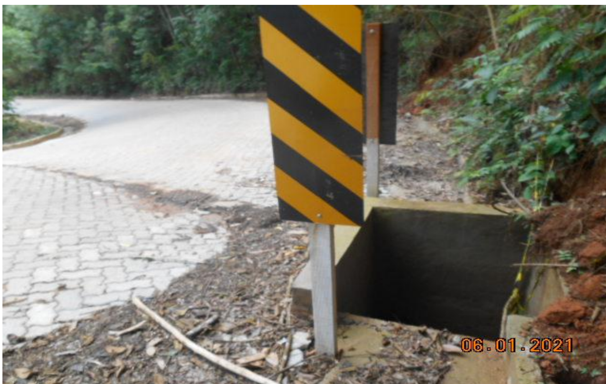
Foto 9 – Vista lateral da rua do Taquaral
