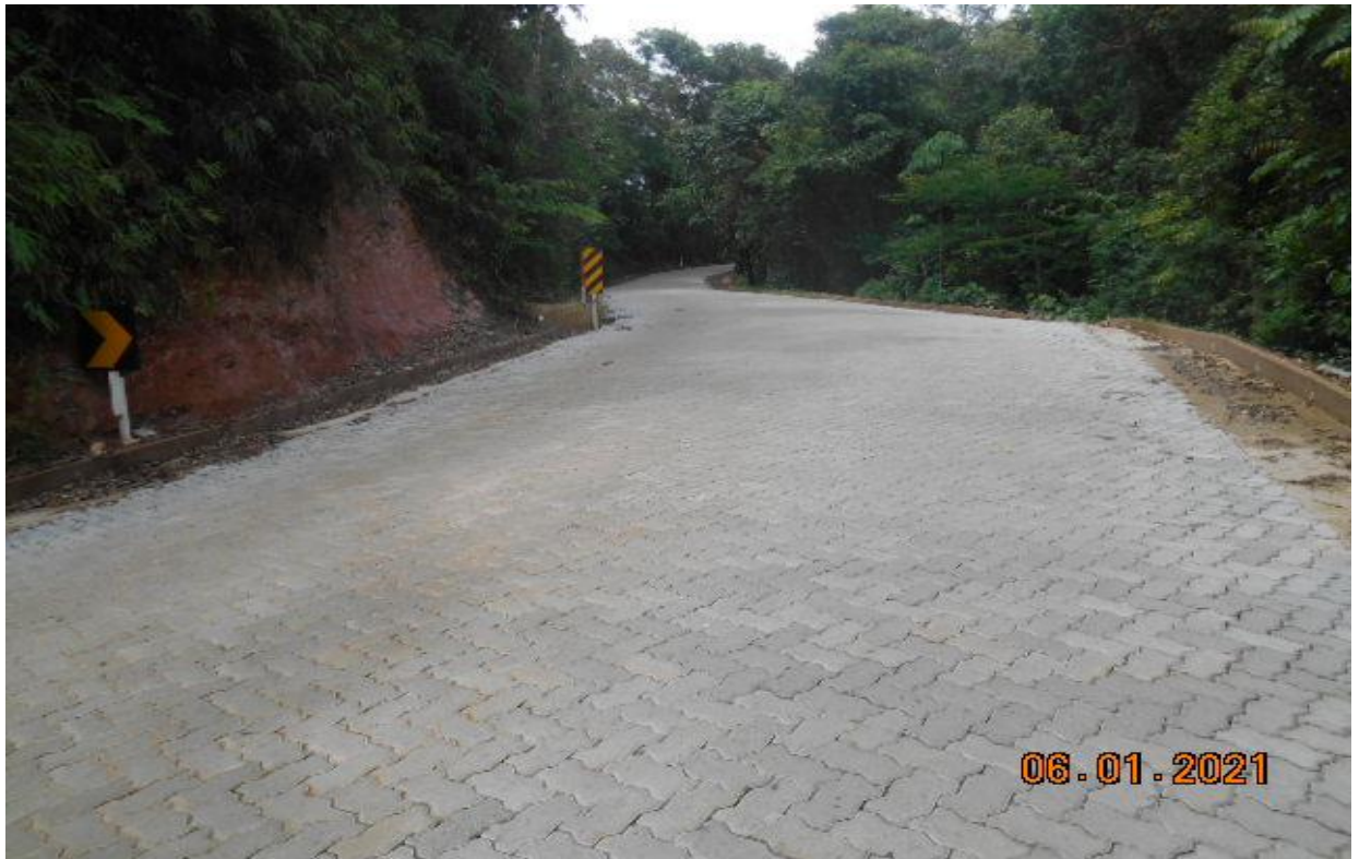
Foto 3 – Vista frontal da rua do Taquaral
