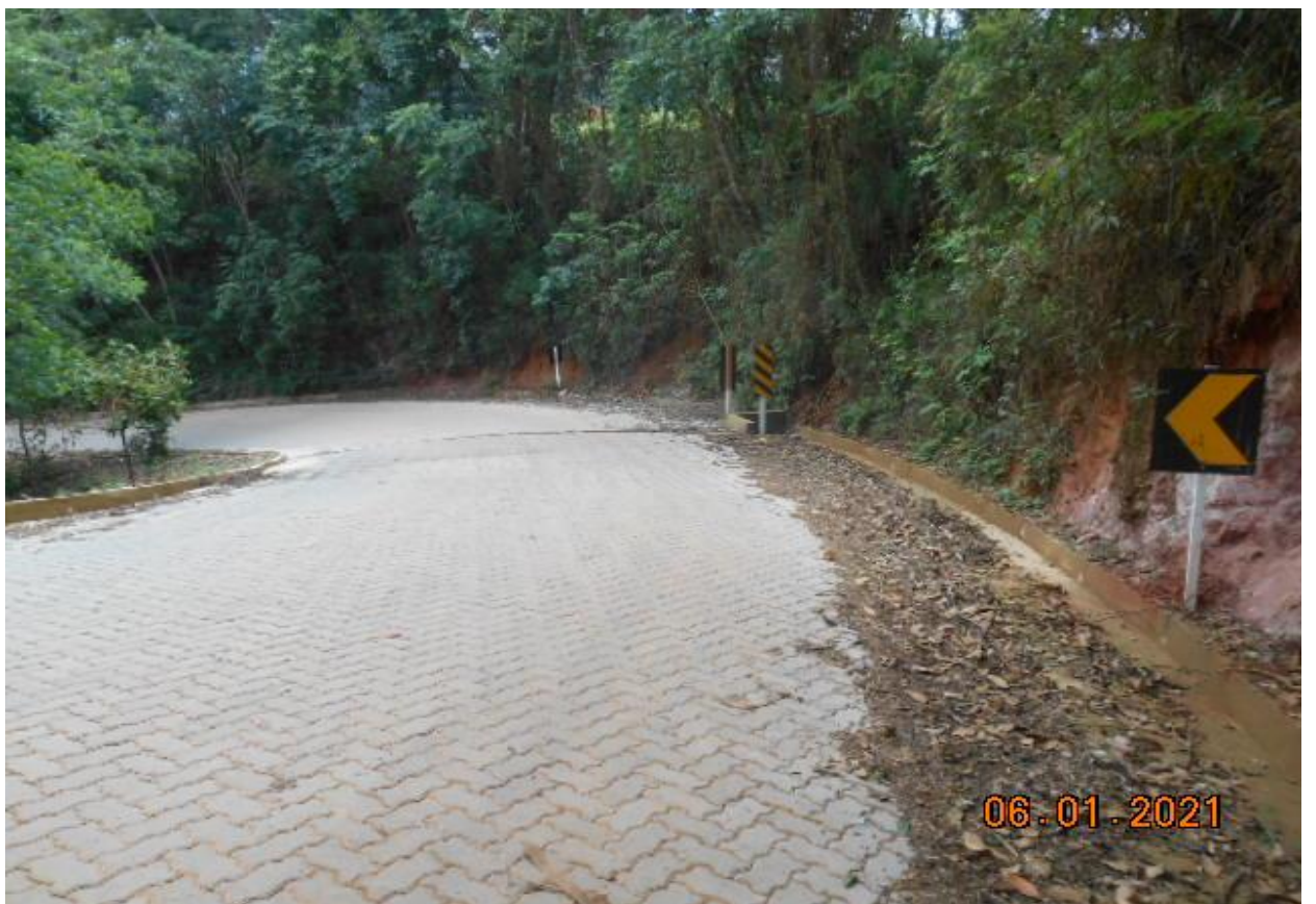
Foto 8– Vista lateral da rua do Taquaral
