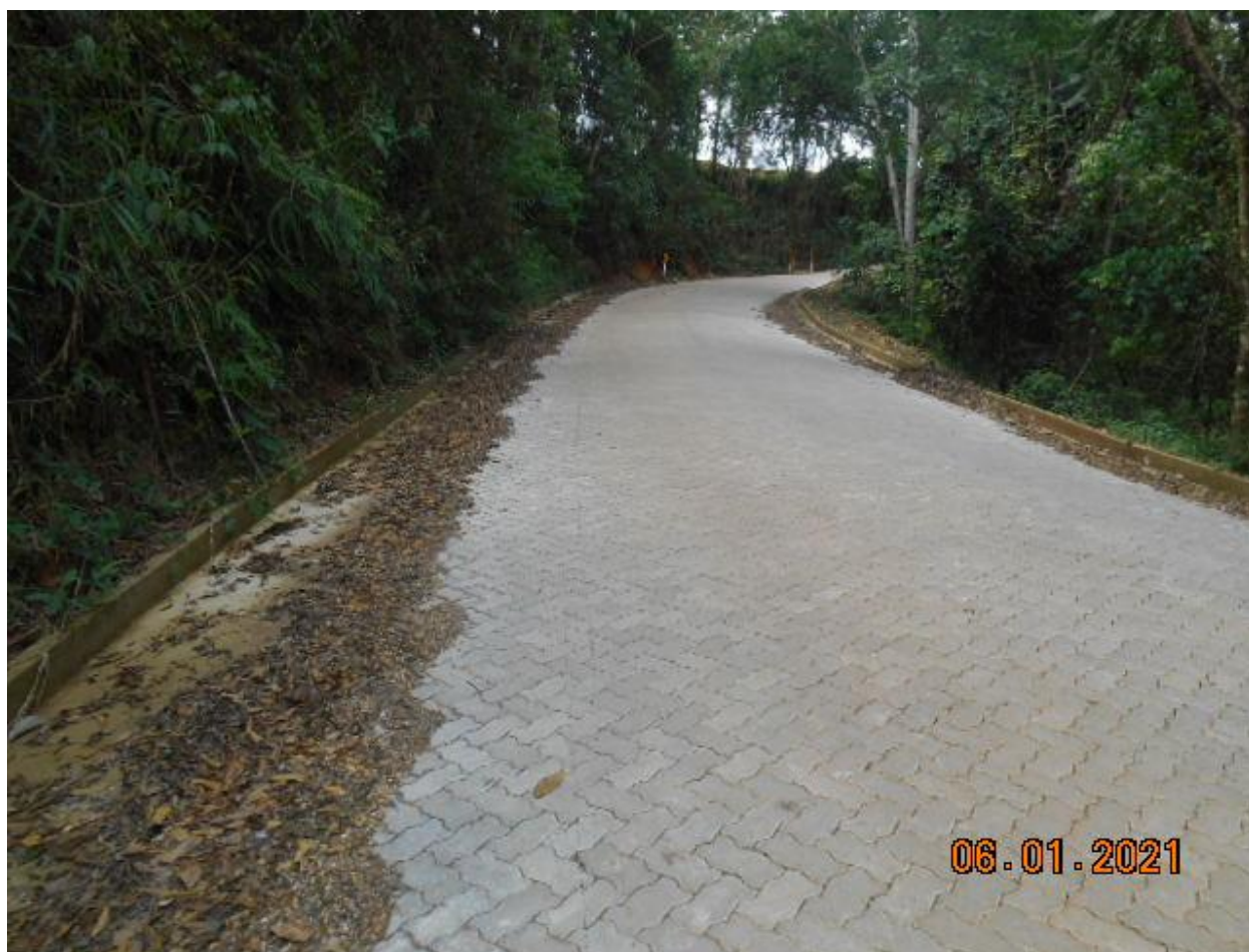
Foto 11 – Vista frontal da rua do Taquaral
