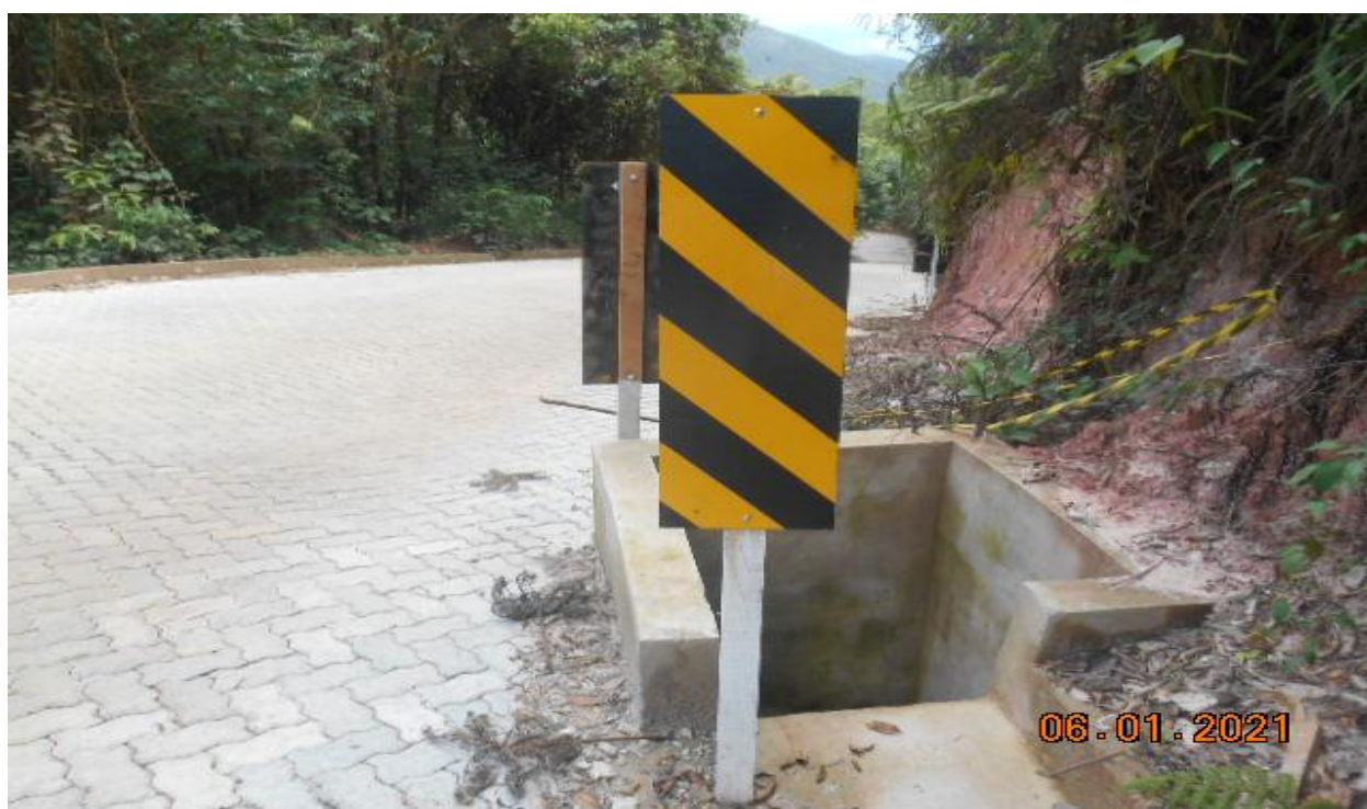
Foto 2 – Vista lateral da rua do Taquaral
