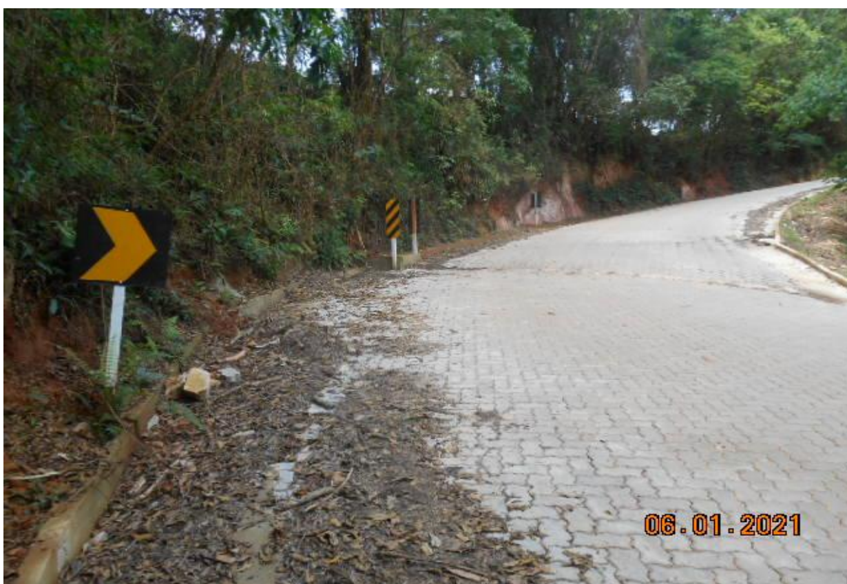
Foto 10 – Vista lateral da rua do Taquaral
