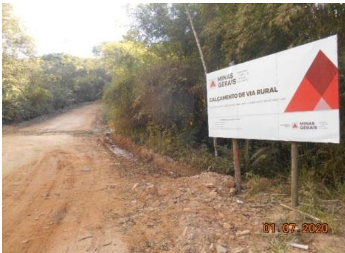
Foto 14 - Vista lateral da rua do Taquaral
