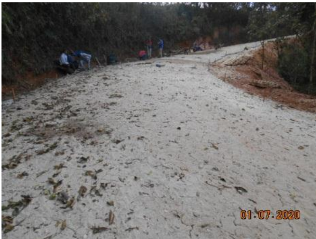
Foto 8 - Vista frontal da rua do Taquaral
