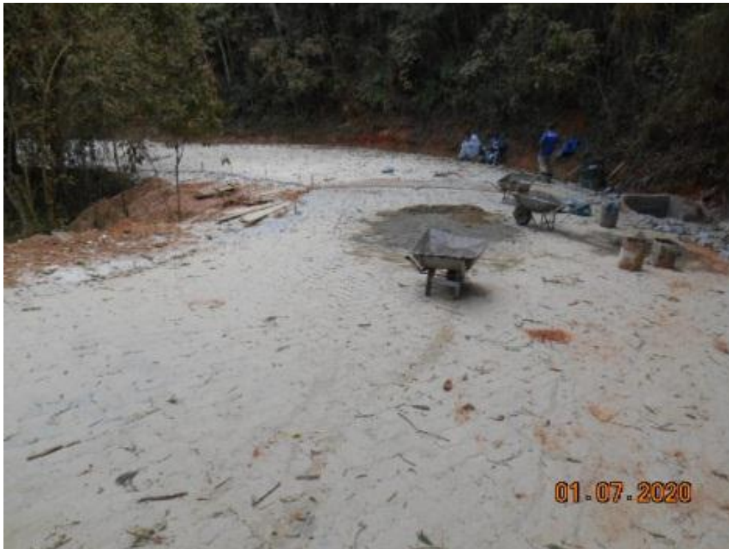
Foto 7 - Vista frontal da rua do Taquaral
