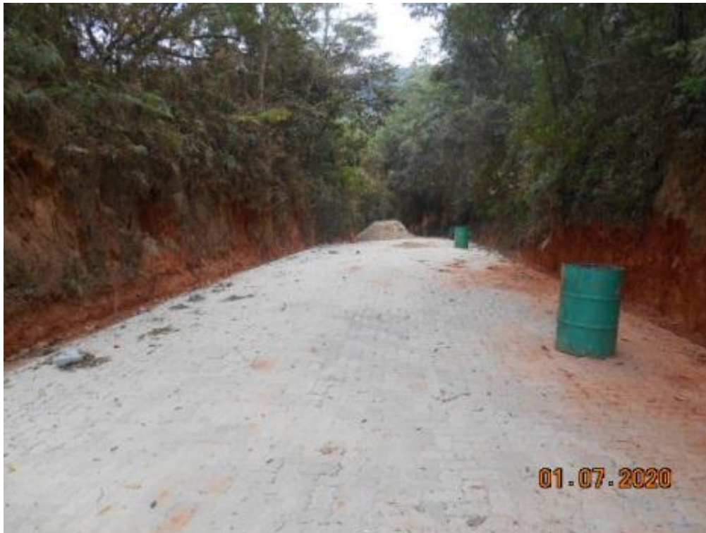
Foto 1 – Vista frontal da rua do Taquaral
